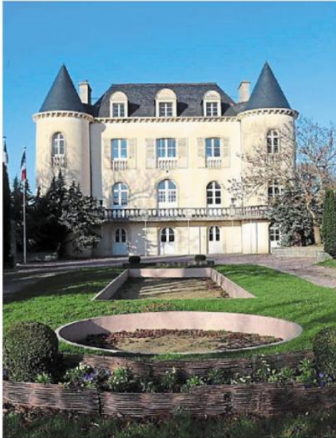
La villa Eugénie est située rue des Français-Libres, non loin de l'église. La structure est saine, mais l'intérieur nécessite d'importants travaux.
